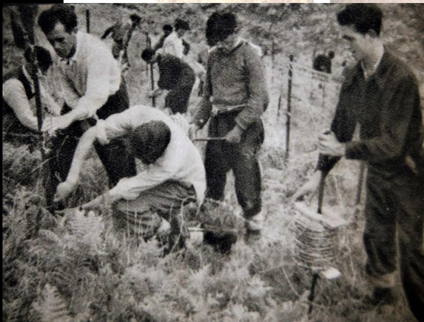
Obreros colocando alambradas en el Cinturón de Hierro. Foto-Museo (Memorial del Cinturón de Hierro)
